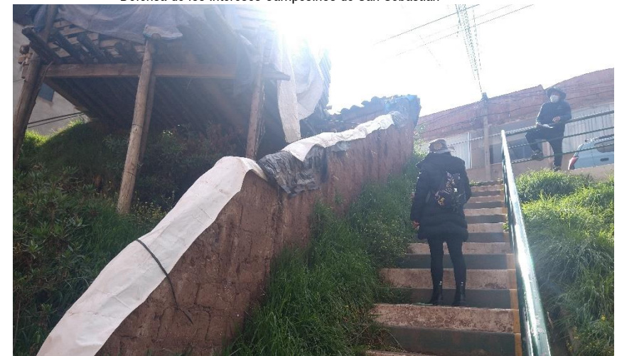
Imagen N° 71: Edificación en muy mal estado de conservación de la APV. Frente de Defensa de los Intereses Campesinos de San Sebastián
