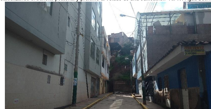
Imagen N° 76: Poste de alumbrado público instalado en la mitad de la acera, disminuyendo y obstaculizando el tránsito peatonal y próximo al volado de una edificación- A.P.V. Agua Buena
