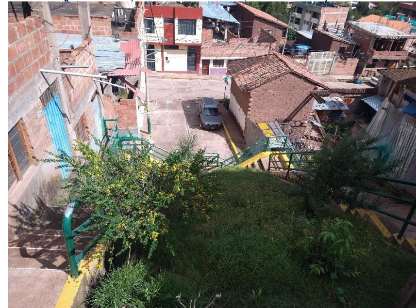
Imagen N° 81: Calle peatonal en la A.P.V. FEDICS, con canal cubierto y descubierto
