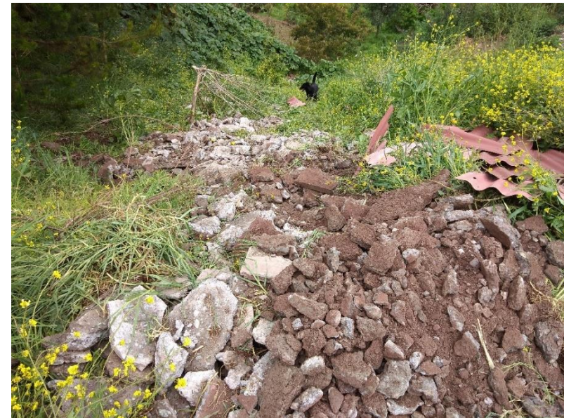
Imagen N° 45: Fotografía de acumulación de residuos de construcción y demolición en el ámbito de estudio de la ZRESS14.
